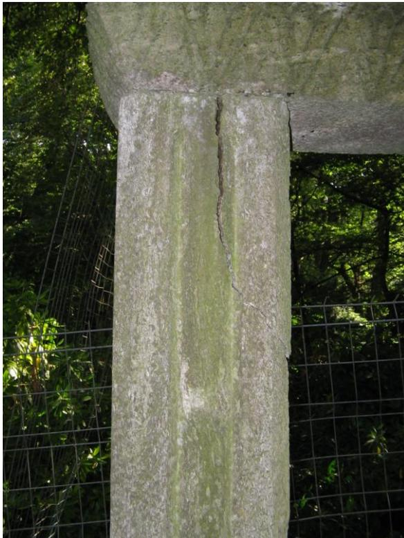
Gebälk einer pergolaartigen, steinernen Grabumfassung mit korrosionsbedingter Absprengung.
