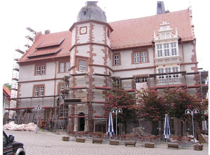
Gesamtaufnahme des Alfelder Rathauses nach Abschluss der Restaurierungsarbeiten, während der Ausrüstung im Frühjahr 2004.
